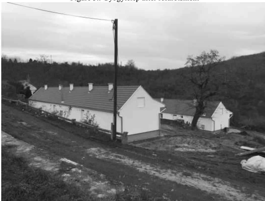
3. ábra: Györgytelep a felújítás után Figure 3.: Györgytelep after refurbishment
