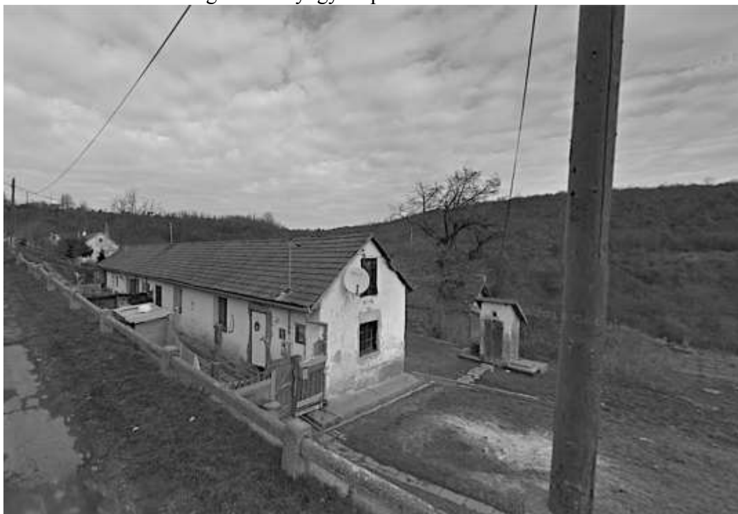
2.ábra: Györgytelep a felújítás előtt Figure 2.: Györgytelep before refurbishment
